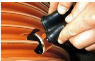
Die Dichtung "falten" und mit der Profilseite "A" einsetzen.
