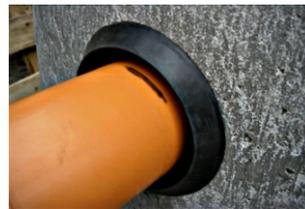
Das Rohr bis zur Markierung einschieben.
