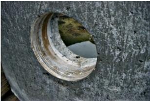
Die Kernbohrung mit einer geeigneten Bohrkronen in dem geforderten Durchmesser herstellen.
