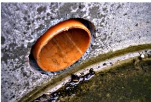
Sicherstellen, dass das anzuschließende Rohr nicht in die Hauptleitung hineinragt!
