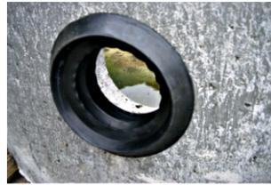
Die Dichtung bis zum Anschlag einpressen (ev. einfallen). Dabei **kein** Gleitmittel verwenden!
