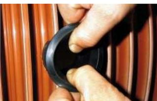
Die Dichtung "entfalten" und soweit zurückziehen, bis die Lippe Kontakt mit der inneren Rohrwandung hat.
