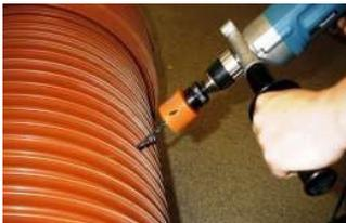
Die Kernbohrung mit einer geeigneter Bohrkronen oder Lochsäge in dem geforderten Durchmesser herstellen.
