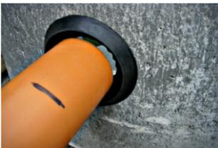
Die Wandstärke messen und eine Markierung am Rohrende anbringen. Die Dichtung mit Gleitmittel (Flexseal weiß) einstreichen.
